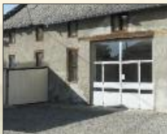
Façade salle des fêtes - Après
