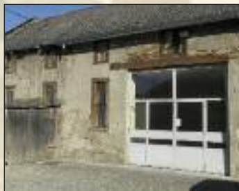
Façade salle des fêtes - Avant
